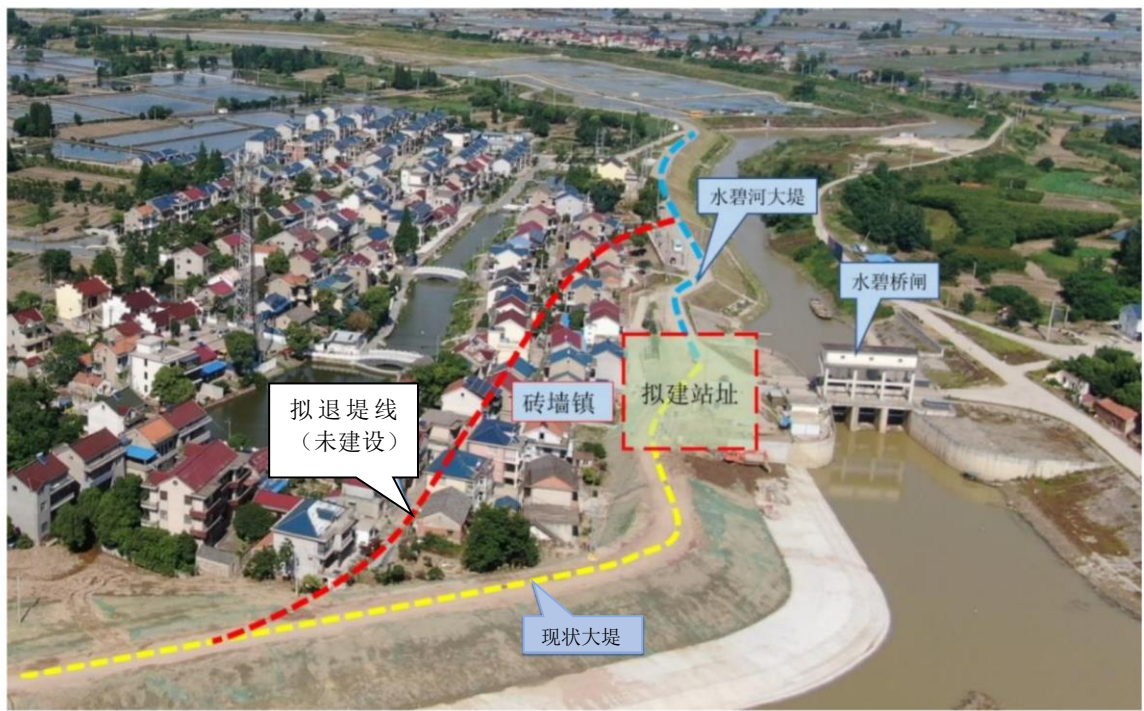
图 2-1 站址处现场航拍照片
